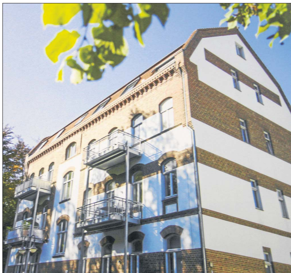
Die Zigarrenfabrik der Gebrüder Bastet an der Viktoriastraße 17. Heute dienen die Räume nach dem Umbau zu Wohn- und Gewerbezwecken.
